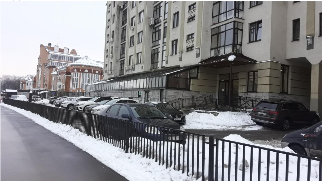
Вид цокольного этажа
